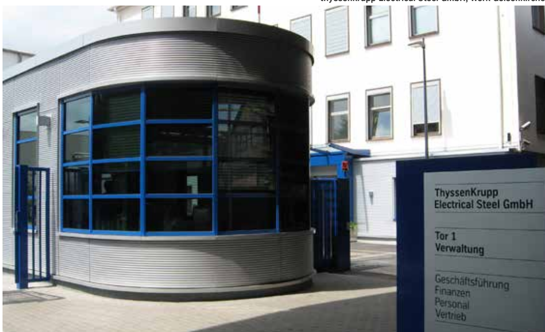
Verwaltung thyssenkrupp Electrical Steel GmbH
